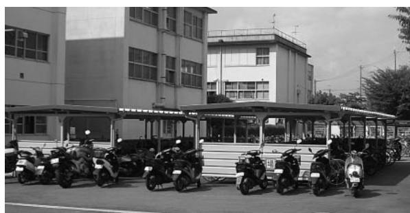
整備された駐輪施設
