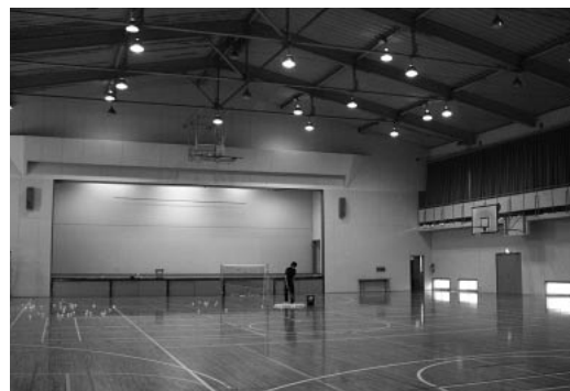
改修された体育館内部
