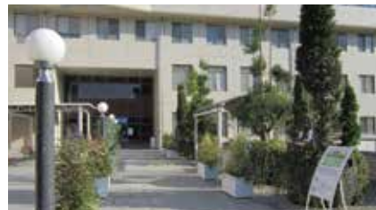
B・C棟玄関
