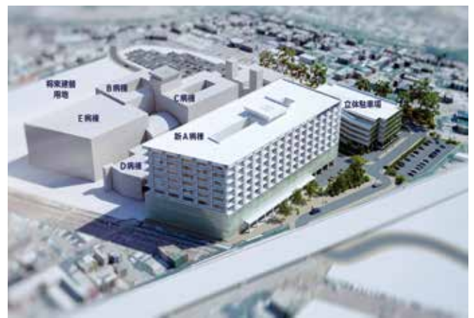
南西からの俯瞰
